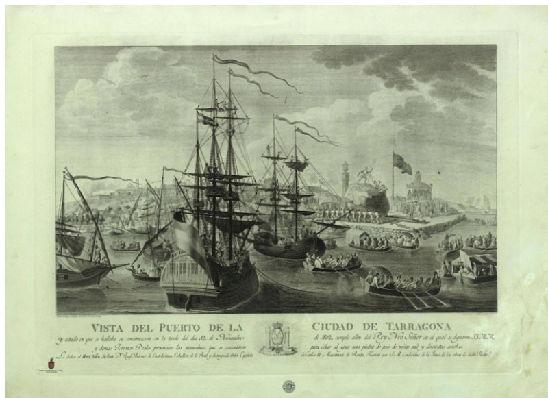
FIGURA 2. Gravat de les obres del port de Tarragona realitzat l'any 1802 amb motiu de la visita de Carles IV, realitzat per Antonio Vázquez.
